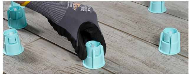
3. Nach dem Aushärten des Klebers werden die Drehköpfe einfach abgeschlagen. Ein leichter Druck auf die Schnellarretierung, und die im Drehknopf verbleibenden Gewindestäbe werden freigegeben.
