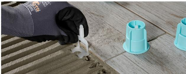
2. Dann wird der Drehknopf über die Gewindelasche geschoben. Diese rastet dabei hörbar ein. Nach wenigen weiteren Umdrehungen sind die Beläge perfekt nivelliert.
